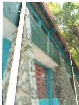
Foto 2: Sustitución de canales para evacuación de aguas pluviales, Anclaje: canal sostenido por pescantes metalicos, incluyendo sus bajadas.
