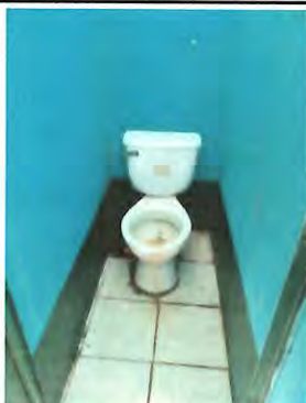
Foto 3: Sustitución de sanitarios lavables, accesorios y conexiones.
